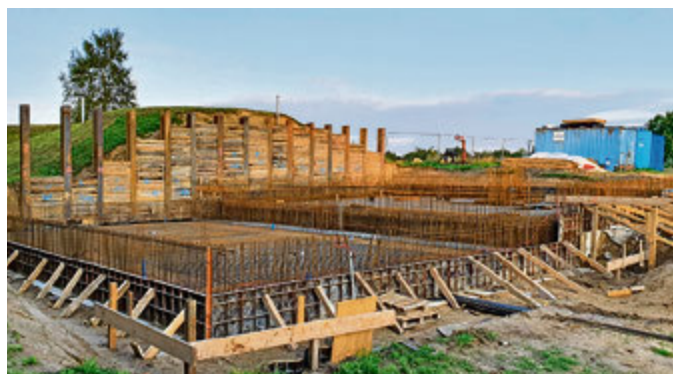
Die Bewehrung für den neuen Speicher steht.
