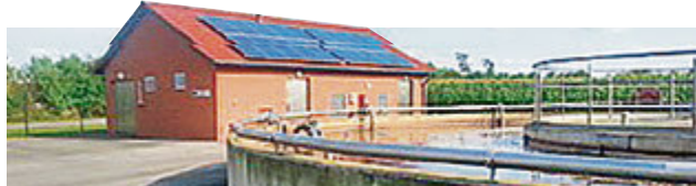
Photovoltaik an der Kläranlage Severin.
