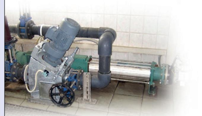
M-Ovas® Zerkleinerer und NEMO® Exzentrerschneckenpumpe
