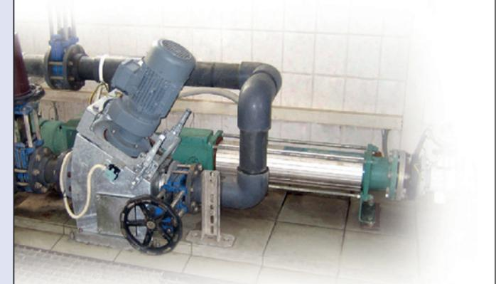
M-Ovas® Zerkleinerer und NEMO® Exzentrerschneckenpumpe
