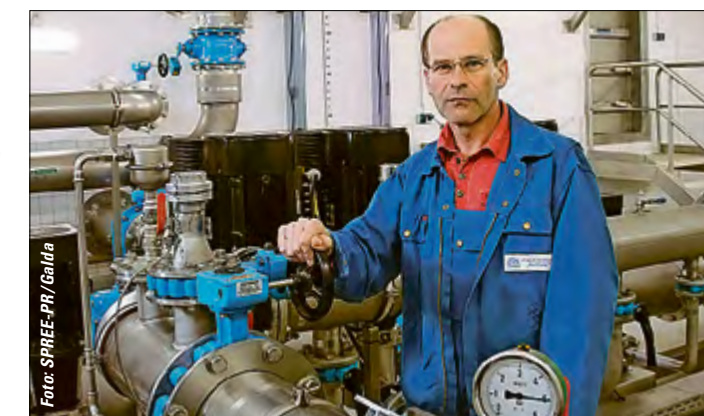
Ingolf Tellinger prüft in der Schieberkammer die Einstellungen. Wasser sieht man hier übrigens lediglich durch ein kleines Fenster in den jeweils 15,35 x 7,55 x 3,5 m großen Speicherbecken.
