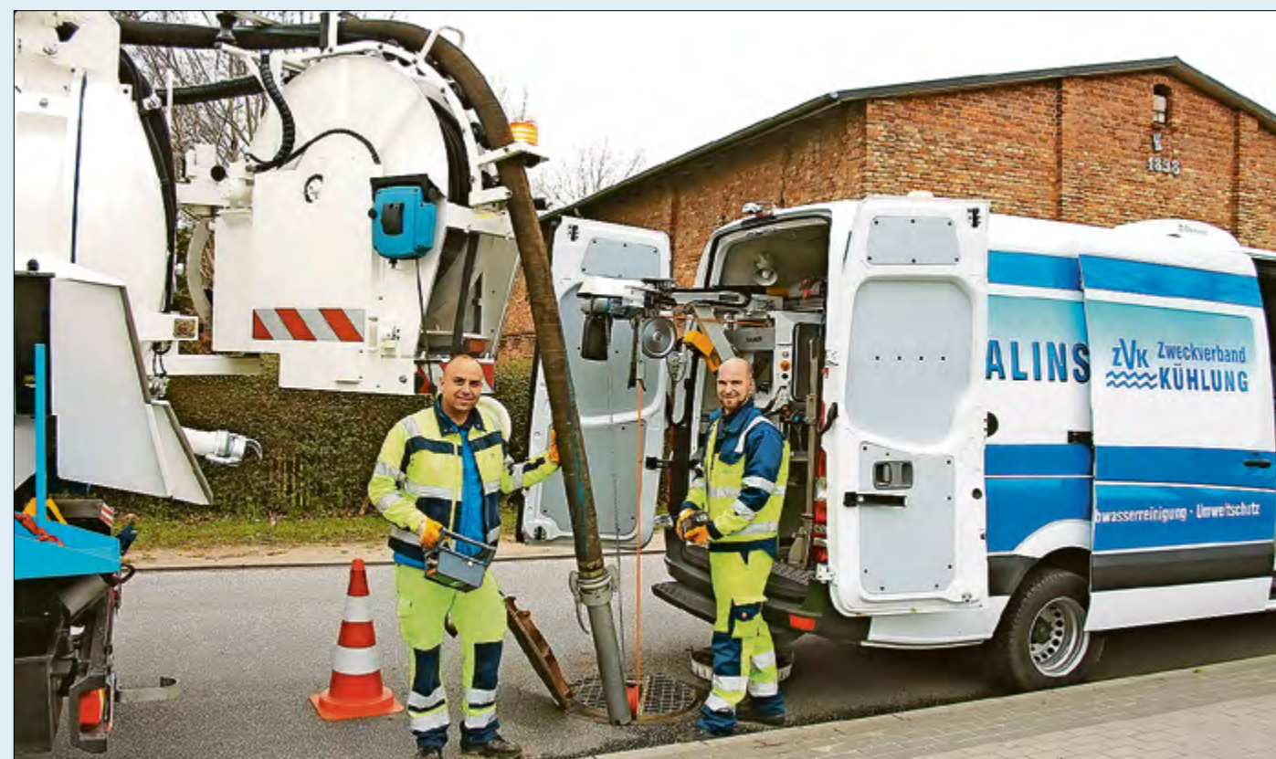
Bevor Inspekteur Hannes Müller (re.) die Kamera in den Kanal herablassen kann, muss Simon Grzeskowiak diesen mit dem Spülfahrzeug reinigen. Das rechte Fahrzeug ist u.a. ausgestattet mit Kameras für Hauptleitungen und Hausanschlüsse.
