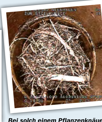
Bei solch einem Pflanzenknäuel bleibt kaum Platz für das Abwasser.
