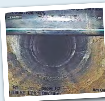
Diese querende Leitung behindert den Durchfluss.
