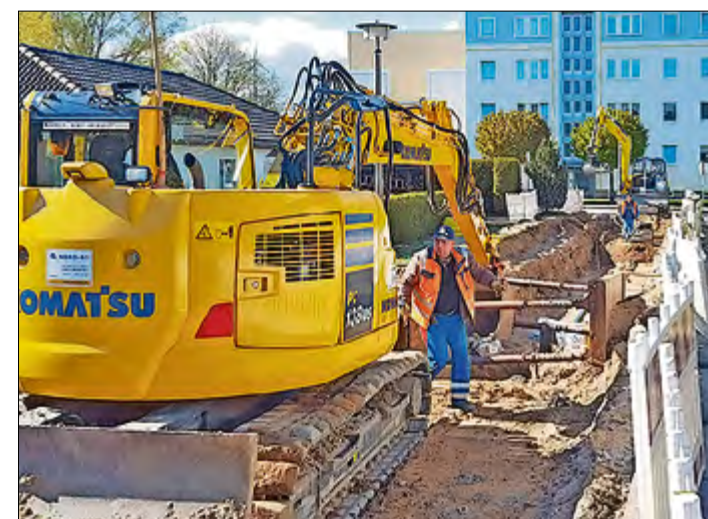
In Neubukow begannen die Arbeiten am dritten Bauabschnitt. Hier werden Trink-, Schmutz- und Niederschlagswasserleitungen erneuert.
