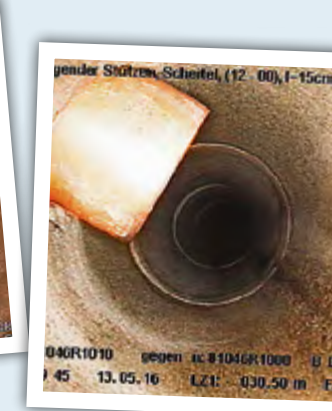
Hier ragt ein Stutzen in den Kanal.
