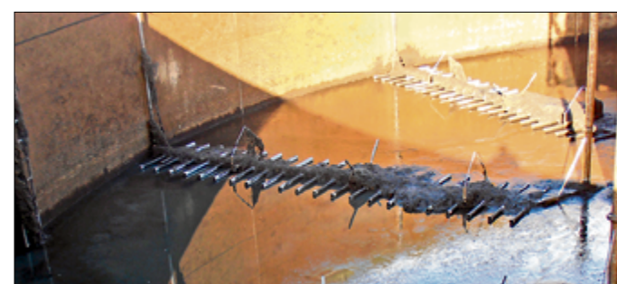
Nach dem Abpumpen des Beckens kommen die Belüfter am Boden zum Vorschein und können gewechselt werden. Foto: ZV KÜHLUNG
