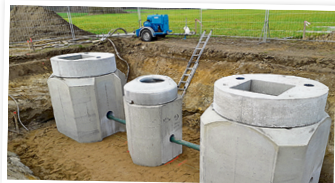
Gut sortiert, die unterirdischen Anlagen des neuen Abwasserpumpwerks Krempin. Foto: ZV
