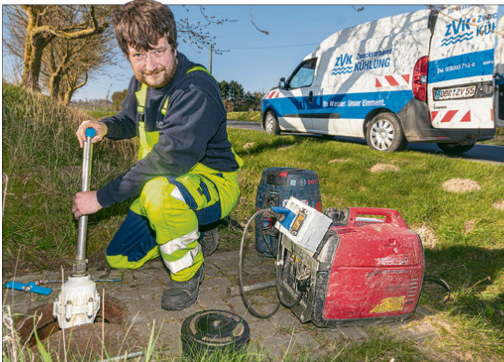
Ricardo Weber prüft hier einen Hydranten. Eigentlich ist er Zählermonteur, eine Arbeit, die bis Mai ebenso wie der Gartenwasserzähler-Einbau wegen der Kontakteinschränkungen ausgesetzt war.
