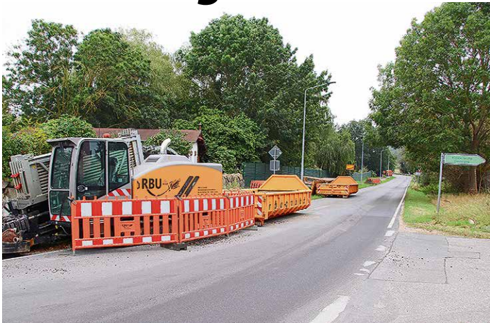
An der Straße entlang verlegten Fachfirmen die neue Druckrohrleitung.
