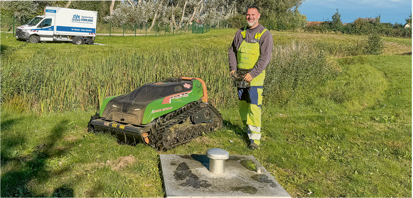
Routiniert schickt Pierre Liedtke den Mähroboter auf die Strecke rund um das Regenrückhaltebecken in Kröpelin. Steile Böschungen, Spundwände und Schachtbauwerke, die zu der technischen Anlage gehören, meistert das Mensch-Technik-Team bestens.
