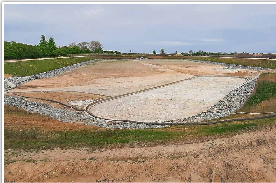
Großbaustelle des ZV Wismar: das Entwässerungssystem für das neue Gewerbegebiet Hornstorf.
