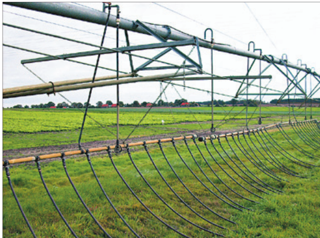
Erst im feuchten Herbst konnten die Beregnungsanlagen eine Pause einlegen.
