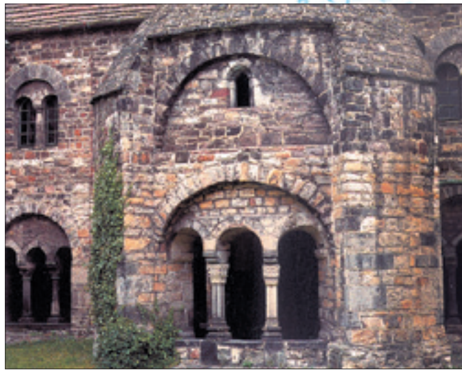
Das Brunnenhaus (ca. 1160 erbaut) der Magdeburger Prämonstratenserabtei Unser Lieben Frauen hat einen kreisförmigen Grundriss.
