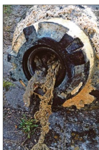
Im Technologiepark in Nienhagen mussten die Fachleute des Zweckverbandes diese verstopfte Pumpe ausbauen.
