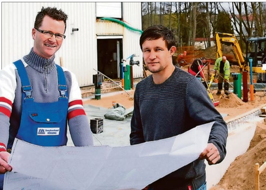
Hinter Abwassermeister Silvan Mund (li.) und Betriebsingenieur Sebastian Zachhuber ist das alte Gebäudeteil der Kläranlage Neubukow zu erkennen. Die Arbeiten laufen auf Hochtouren.
