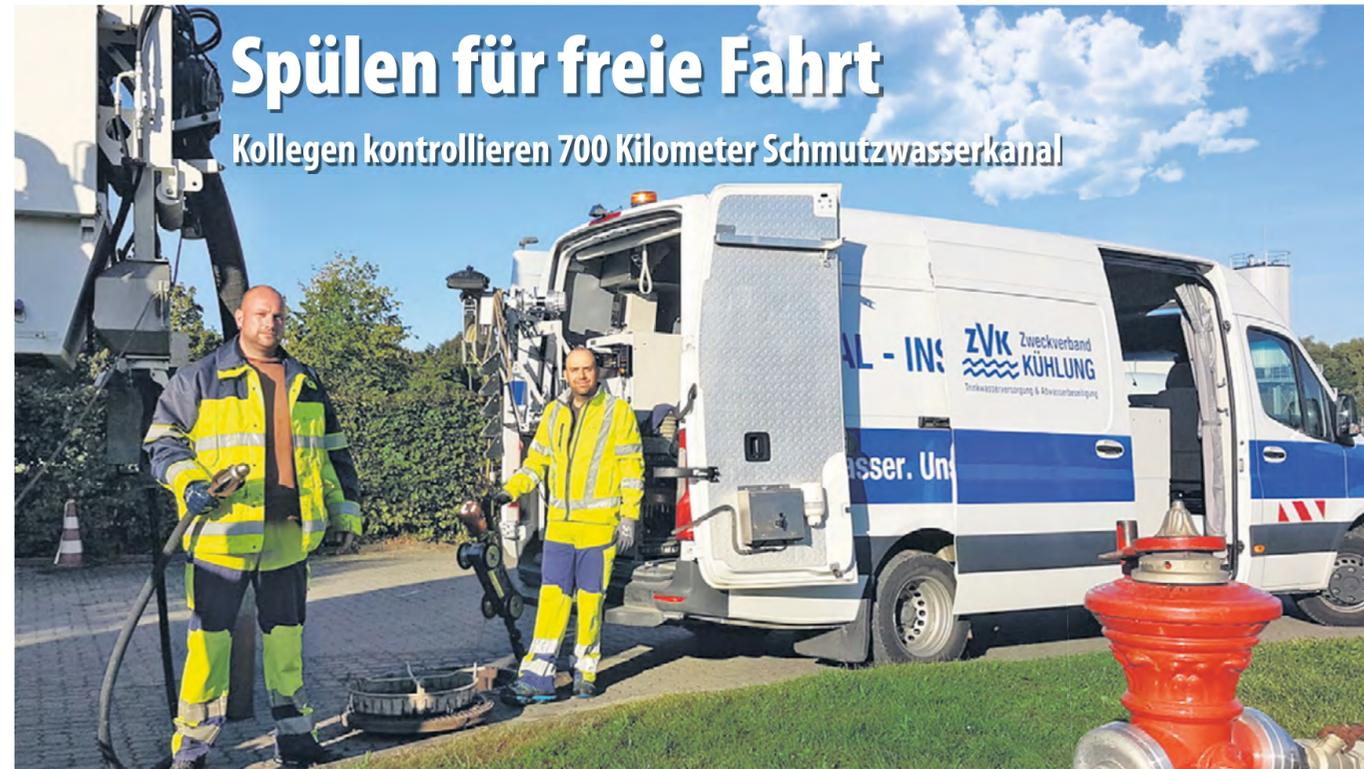
Markus Mross (l.) bedient das Spülfahrzeug, dessen Putzaktion Voraussetzung für die Kanalinspektion durch Simon Grzeskowiak ist.
